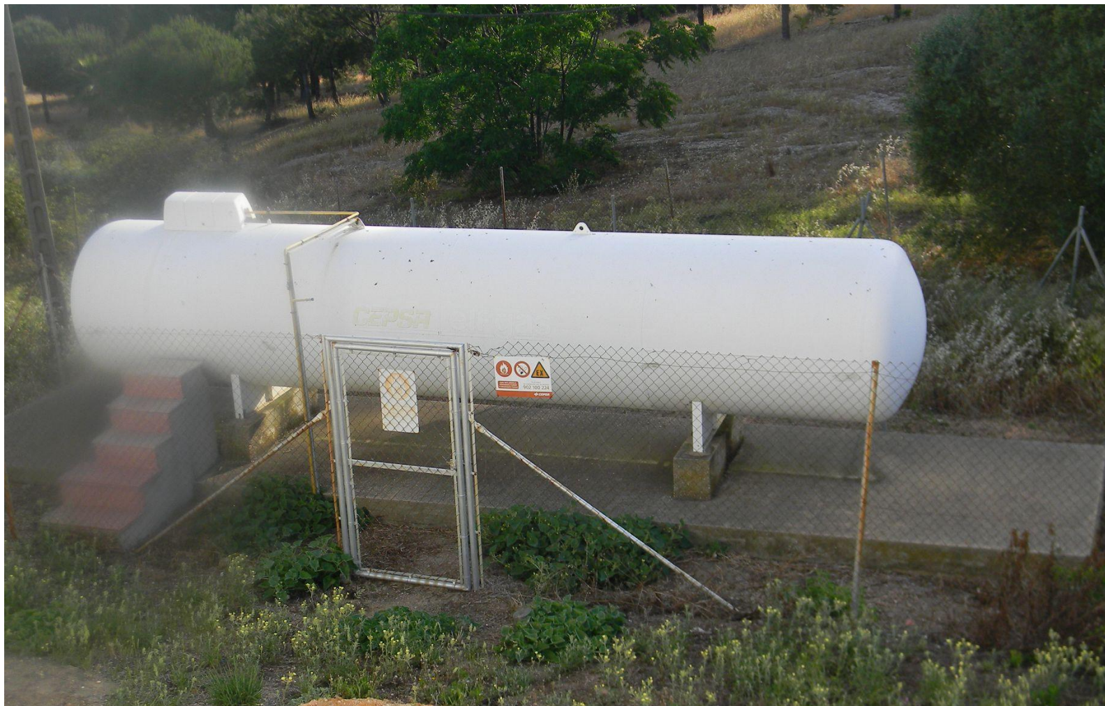
Imagen del depósito de gas propano de la sede de La Rábida y las medidas de prevención de la contaminación de suelos. Fuente: Sostenibilidad a Medida
